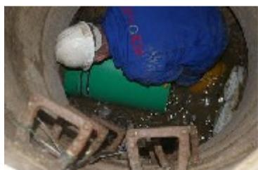
Mit der Zugeinheit "Seilberster TERRA-EXTRACTOR" werden Kurzrohrmodule in marode Abwasser- oder Versorgungsleitungen eingezogen.
