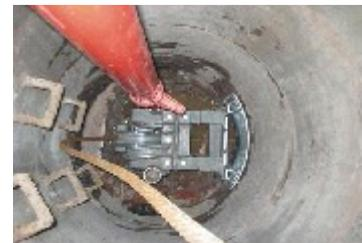
Anschließend erfolgte am Seilanfang die Montage der Seilkupplung zum Kaliberkopf DN 500 im Zielschacht. Danach wurde das erste Kurzrohrmodul mittels PIPe-Gestänge und Spannplatte mit dem Kalibrierkopf verbunden.
