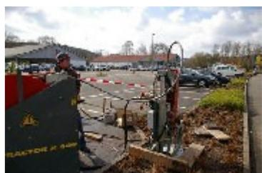
Hinter der Kaliberspannplatte am letzten Rohr des Rohrstranges wird ein Kraftsensor montiert, der über ein Kabel mit einem Computer verbunden ist.
