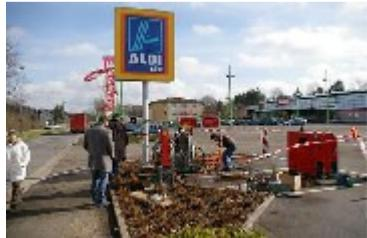
Das Tiefbauamt Völklingen kontaktierte den Kanalsanierungsspezialisten Firma Karo-San GmbH aus Illingen. Nach Durchsicht der Dokumentation und Beurteilung der Altrohrsituation kam man zu dem Entschluss, die Sanierungsmaßnahme mit dem Seilberster TERRA-EXTRACTOR X 400 im PIPé-Verfahren in geschlossener Bauweise von Schacht zu Schacht durchzuführen
